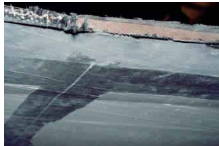
In quest'immagine, una coperta realizzata in sandwich con l'utilizzo di Prepreg. Sotto, si nota il manufatto in sandwich, stratificato in carbonio e anima di Airex
